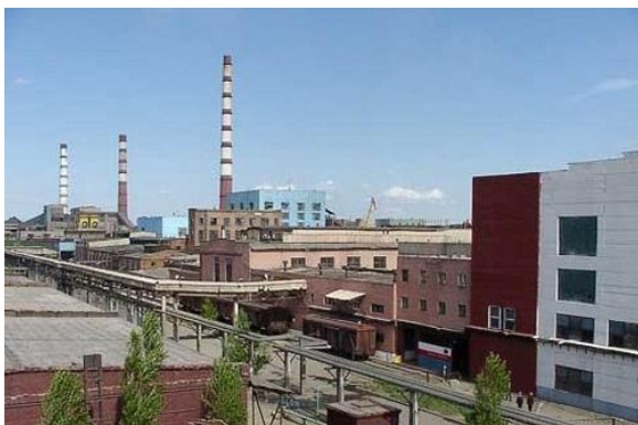
Рис. 2. Общий вид Усть-Каменогорского титано-магниевого комбината
