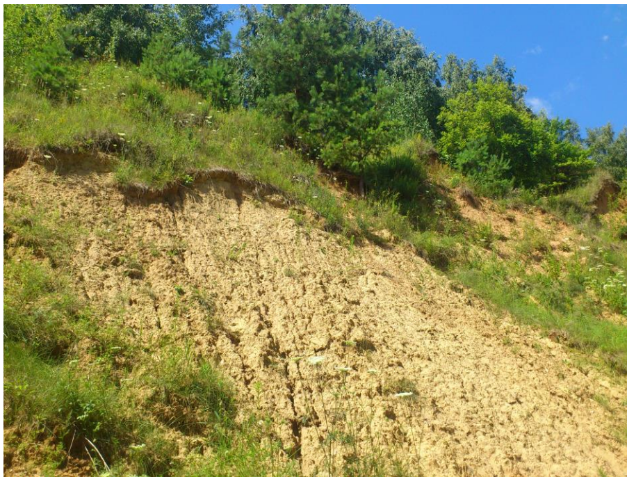
Рис. 1. Оползень на берегу р. Днепр
