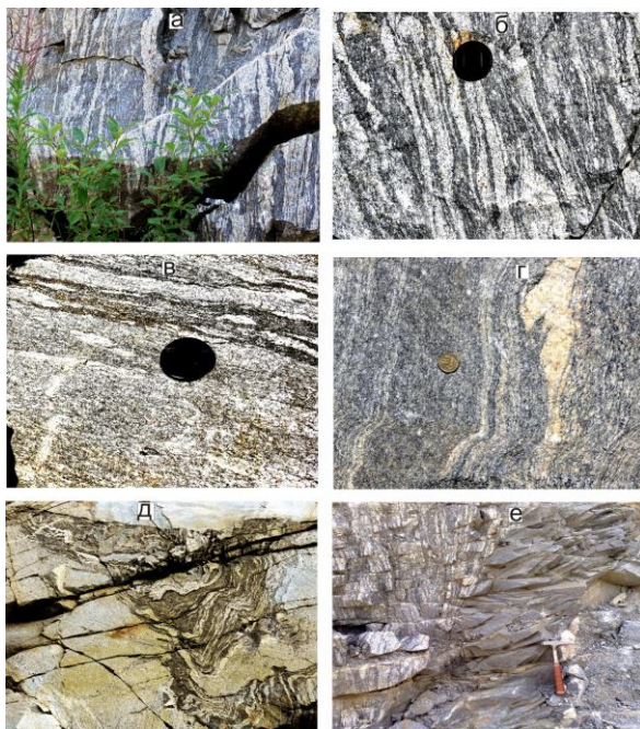
Рис. 2. Мигматиты Каменского массива (водовод 4 блока Белоярской АЭС): а, б – типичная полосчатая текстура мигматитов; в, г – формы обособления лейкосомы гранитного состава; д – ксенолит мигматита в граните; е – дайка кварцевого диорита 430, секущая полосчатые мигматиты
