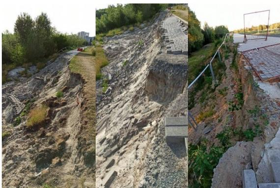
**Рис. 9.** Проявление опасных инженерно-геологических процессов, Микрорайон «Шведская горка» (фото автора)
