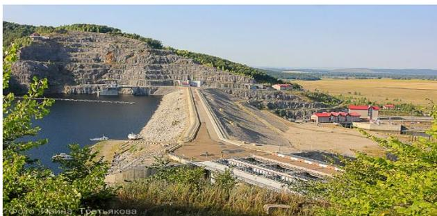
**Рис. 2.** Плотина Юмагузинского гидроузла. На заднем плане скальные породы левобережного примыкания
