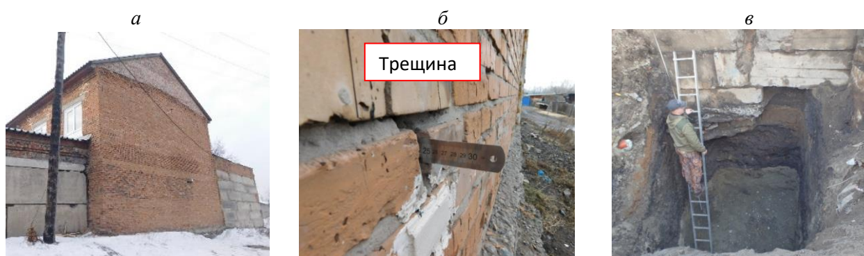
Рис. 4. Нежилое здание, расположенное по адресу: г. Минусинск, ул. Красноармейская, 2. а – общий вид; б – деформированный участок стены, в – шурф вблизи деформированного участка стены
