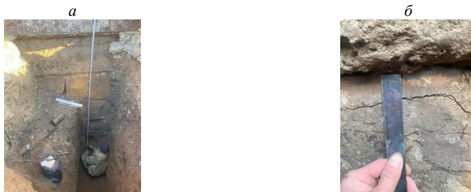
Рис. 2. Операторная, сервисное здание с автомойкой многотопливной автозаправочной станции с пунктом автосервиса (г. Абакан): а – обмеры фундамента, б – деформации фундаментов
