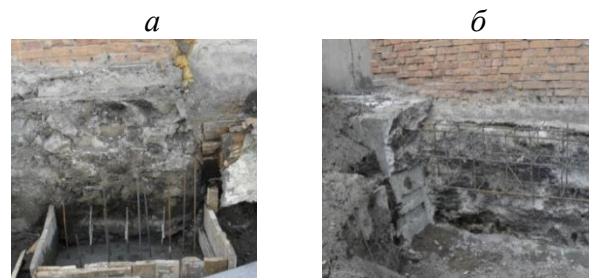
Рис. 6. Работы, выполненные по усилению фундаментов нежилого здания, расположенного по адресу: Красноярский край, г. Минусинск, ул. Красноармейская, 2
